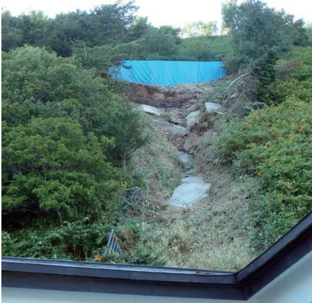
稚内市量徳寺裏の崖錘・強風化層のすべりと破壊され宙づりとなった土留工
